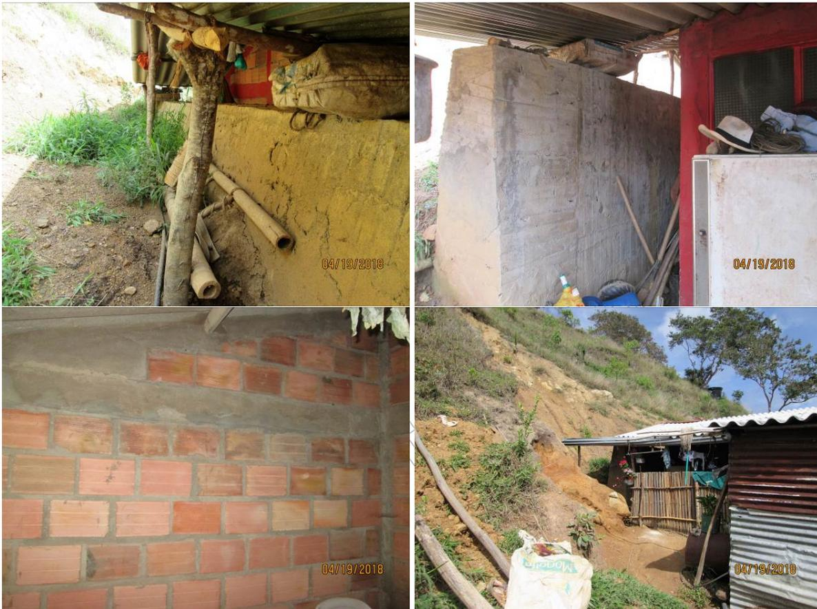
FOTOGRAFIAS 9, 10, 11, 12: MURO DE CONTENSIÓN, MURO INTERIOR Y CUBIERA DE LA VIVIENDA UBICADA EN PEÑA LIZA. (FOTOGRAFIAS DILIGENCIA DE INSPECCIÓN).
