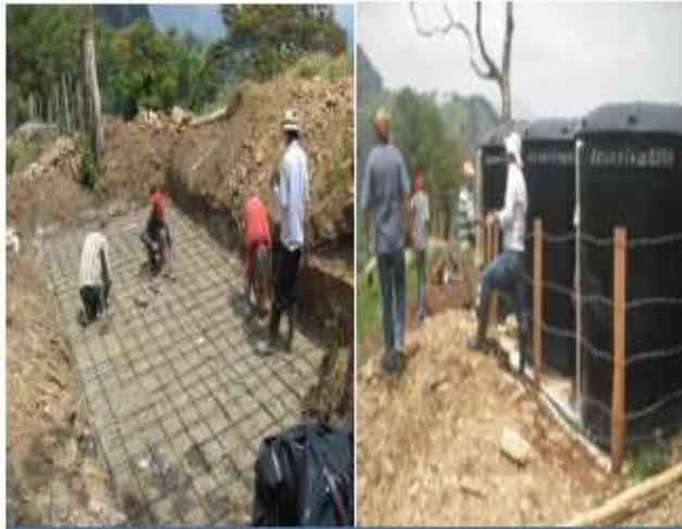
SE CUMPLIERON CON LAS CONDICIONES Y ESPECIFICACIONES TECNICAS DE CONSTRUCCION E INSTALACION DEL TANQUE, LA PLACA PISO SE CONSTRUYO CUMPLIENDO CON LO EXIGIDO, PARA LOS TANQUES DE ALMACENAMIENTO Y ACCESORIOS SE CONSTATO CALIDADES Y GARANTIAS, SE REALIZARON PRUEBAS DE ESTANCAMIENTO Y FUNCIONABILIDAD DEL SUMINISTRO DE AGUA
