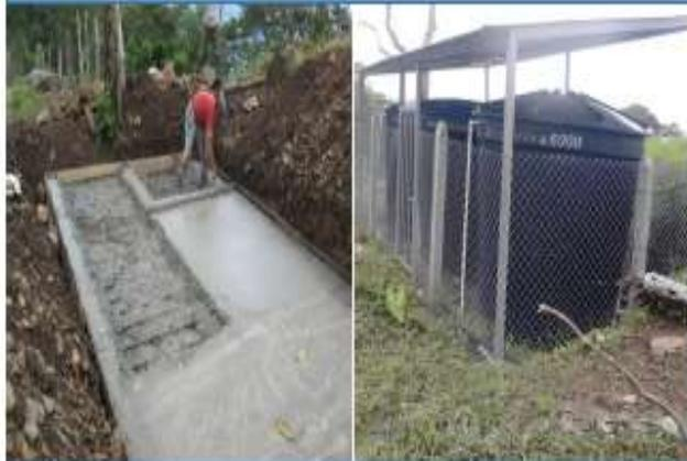
PARA SEGURIDAD Y PROTECCION SE CONSTRUYO CERRAMIENTO Y SE MONTO UNA CUBIERTA, ESTA REGION SE CARACTERIZA POR SUS ALTAS PRECIPITACIONES E INESTABILIDAD DE SUS TERRENOS MONTAÑOSOS
