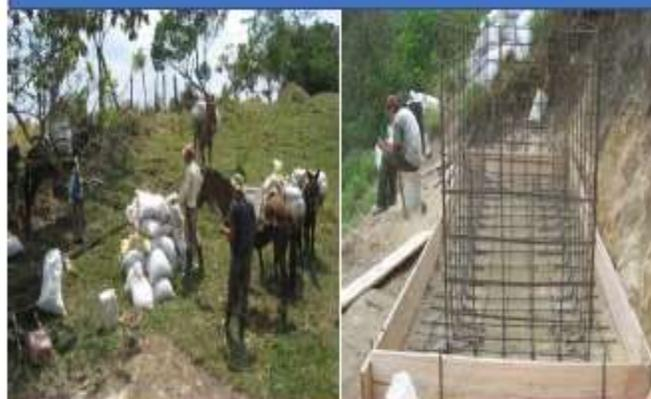
DEBIDO A LA DEFICIENTE PLANIFICACION DEL PROYECTO NO SE TUVO EN CUENTA LAS CONDICIONES REALES DEL TRANSPORTE DE MATERIALES Y DESPLAZAMIENTO DEL PERSONAL DE OBRA, LA IMAGEN DEJA VER LAS DIFICILES CONDICIONES DE ACCESO, MATERIALES CARGADOS A LOMO DE MUJLA EL PERSONAL DE MANO DE OBRA SE UTILIZO EN SU MAYORIA DEL SECTOR SE CUMPLIO CON LAS CARACTERISTICAS TECNICAS EXIGIDAS POR EL CONTRATANTE.
